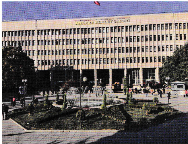
Das Gerichtsgebäude in Ankara
